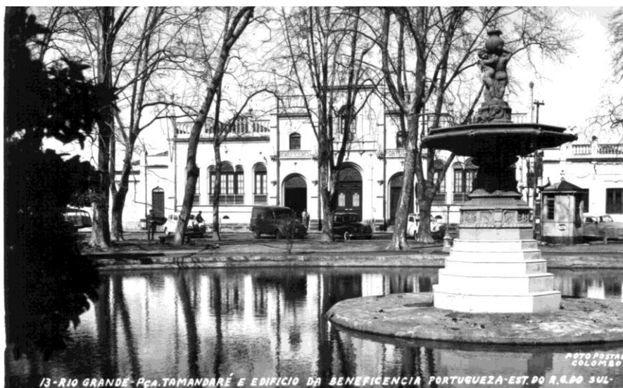
Figura 3 - Chafariz adquirido pela Companhia Hidráulica Rio Grandense com o Hospital da Beneficência Portuguesa ao fundo (meados do século 20)
