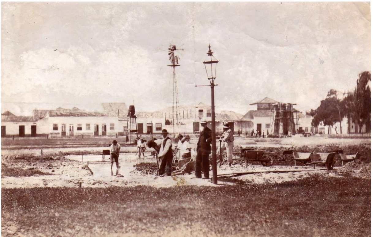
Figura 9 - Obras na Praça em 1895 (vista para atual Rua Luiz Lorea)
