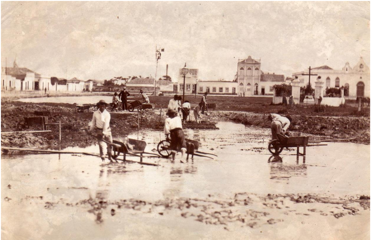
Figura 8 – Obras na Praça em 1895 (vista para a atual Rua General Vitorino)
